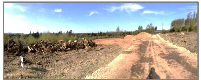
Abb. 20: Windkraft-Baustelle im Naturpark Kaufunger Wald
